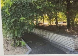
⑩藤棚の入口 藤棚の入口は蔓が垂れてきており、トンネルに入りづらい印象を与えてしまっている。
