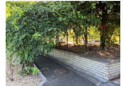
⑩藤棚の入口 藤棚の入口は蔓が垂れてきており、トンネルに入りづらい印象を与えてしまっている。
