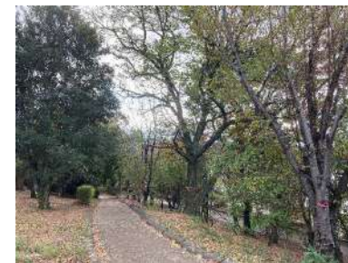
⑨園路 手入れが必要な樹木や、部分的な舗装のたつきが見られる。
