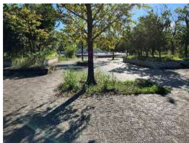
②舗装 舗装は石畳調のタイル張りで美術館調の雰囲気演出されている。
