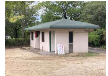
④トイレ トイレが近接して設置してあるが、古くて使いにくいとの声も聞かれる。
