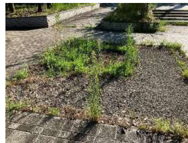
⑨植栽樹 一部の植栽樹には砂利が敷かれ雑草が生えないようになっている。
