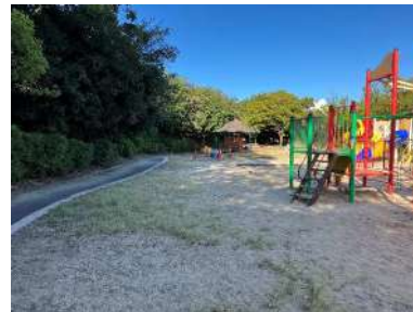
⑤砂地の地面 現在は砂地の地面になっており、車いす等での通行が難しい。
