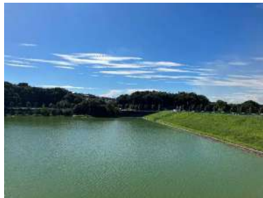
⑥堤防 浸水対策のために2012年に強化整備された堤防の法面は緑化されている。
