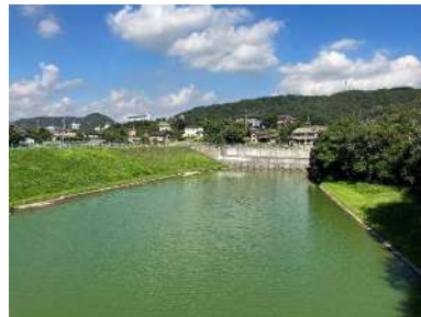
⑦放水口 貯水機能を持つ春日池が放水量を調整するための設備も見ることができる。
