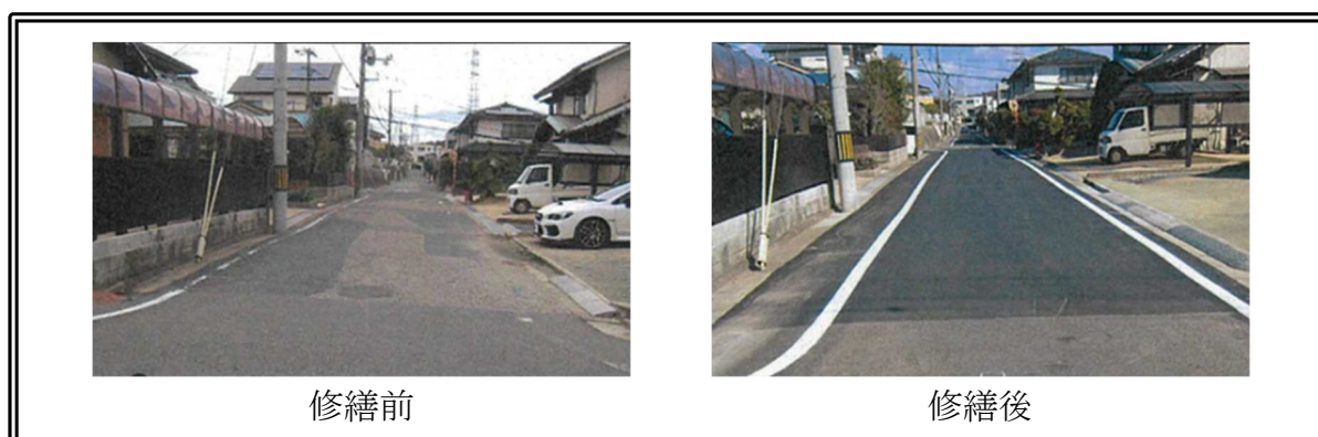
図2-1 区画線の修繕状況
