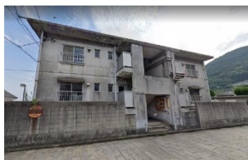
図表 西側拠点の既存建物
