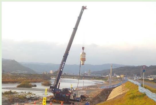
【芦田川堤防浸透対策】
