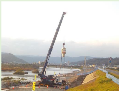
【芦田川堤防浸透対策】
