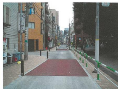
写真 2-16 ボラードの設置事例 (東京都新宿区)
