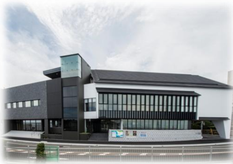
【鞆支所・鞆公民館】
