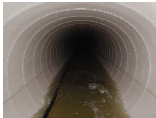
【下水道管渠耐震化工事（施工後）】
