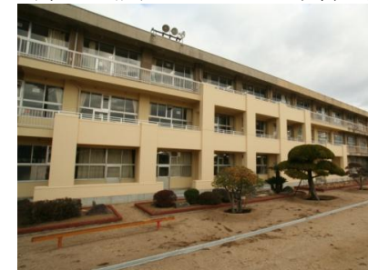
【御幸小学校耐震補強工事】
