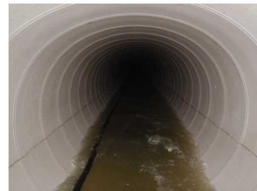
【下水道管渠耐震化工事(施工後)】
