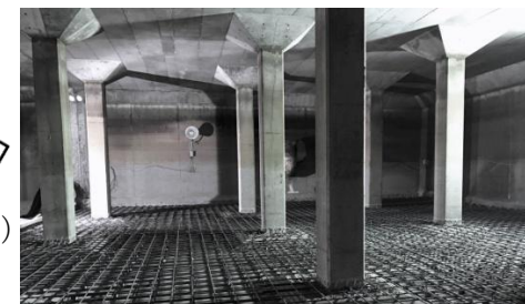
【久松台配水池耐震補強工事】
