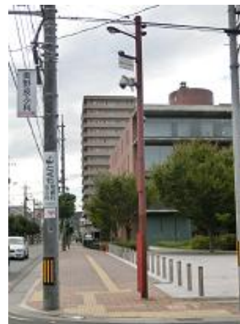
【防犯カメラ設置例】
