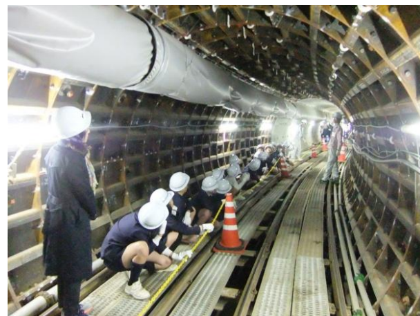
【中央2号・中央5号幹線築造工事(見学会)】
