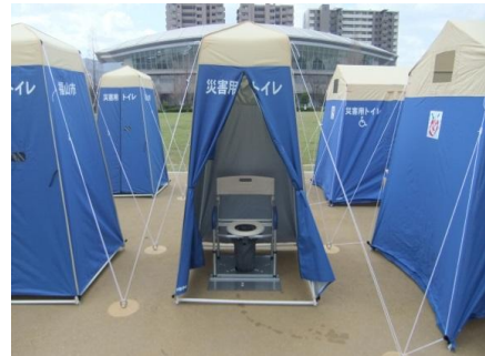
【マンホールトイレ設置のイメージ】
