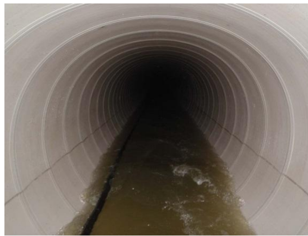
【下水道管渠耐震化工事（施工後）】
