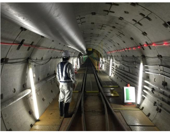
【中央2号・中央5号幹線築造工事状況】
