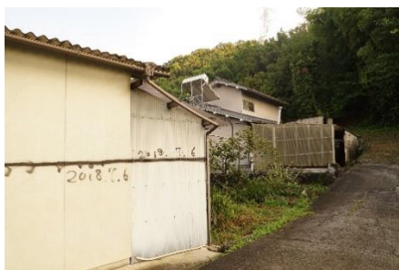
防災の記録（平成30年水位の記録）
