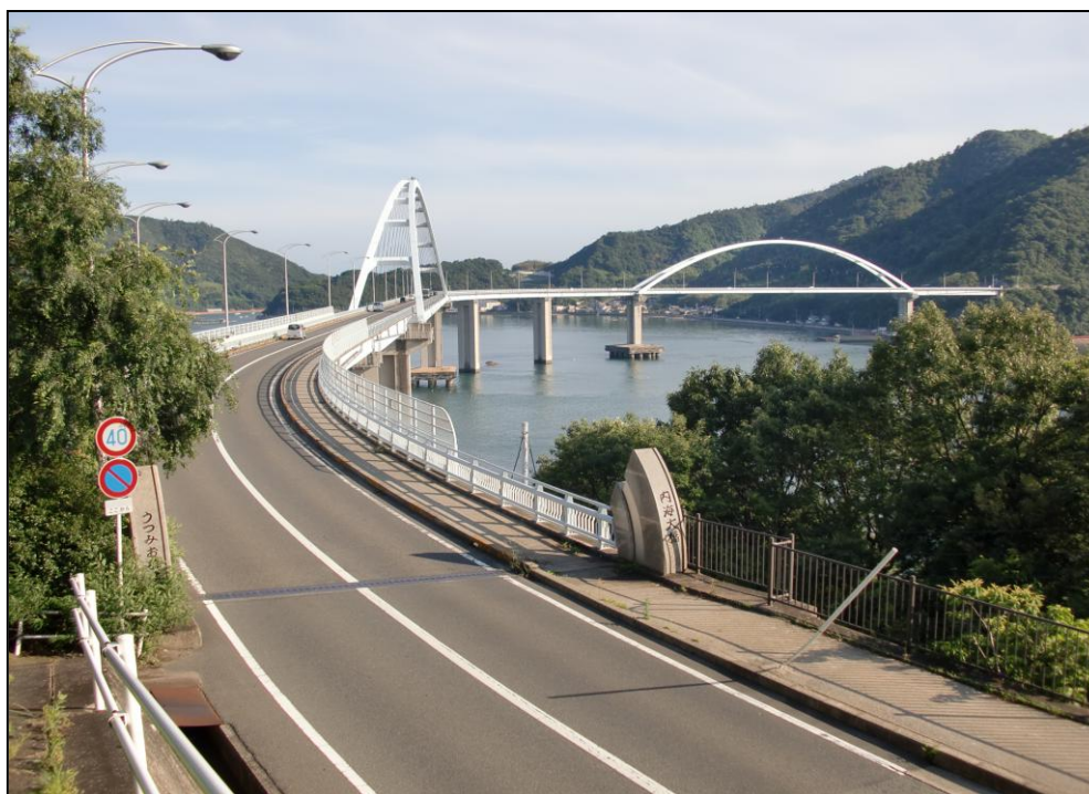
平成元年に開通した内海大橋
