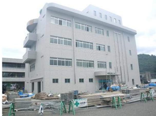
【水質管理センター棟（施工中）】
