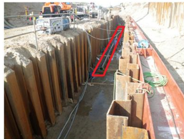
【導水管の布設状況】
