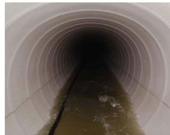
【下水道管渠耐震化工事完成】
