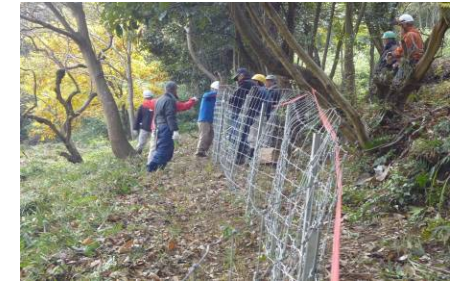
【山手・津之郷町「いのしし防護柵の設置」】
