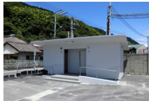
【鞆地区都市整備用地便所整備】
