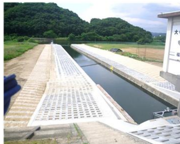
【取水施設の耐震補強】
