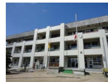
【網引小学校耐震補強工事】
