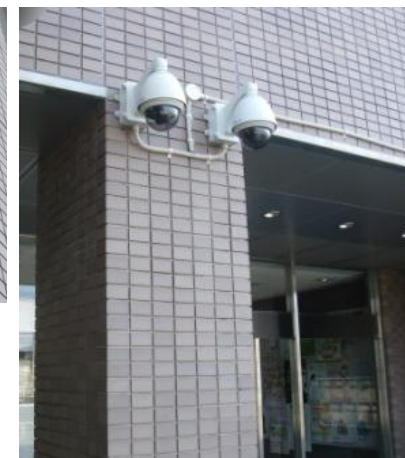
【公共施設 出入口】
