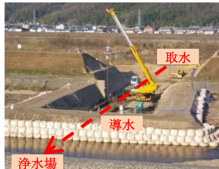
【導水管布設、布設替工事の施工状況】
