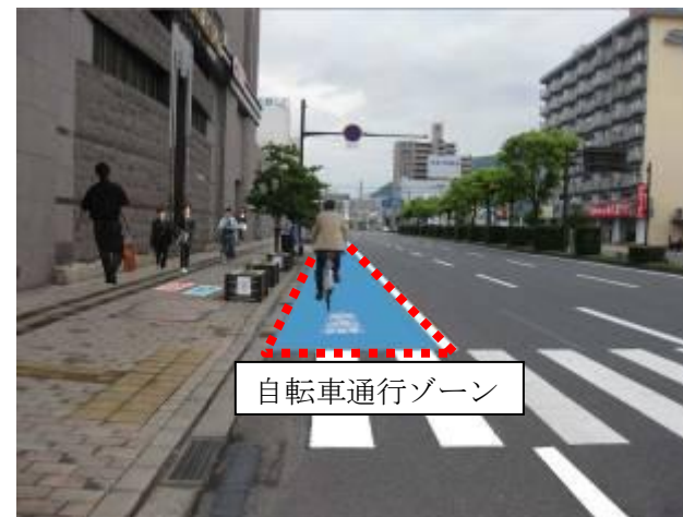
【自転車走行空間整備】
