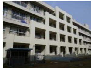
【校舎の耐震補強】
