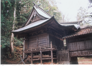
入母屋造の本殿
