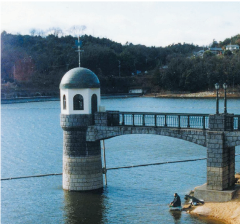
大池の取水塔
