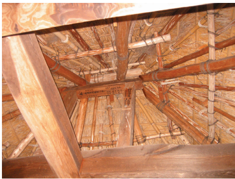
上林の辻堂の屋根内部(下から撮影)
