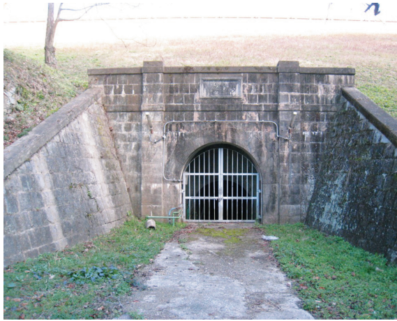
水源池土堰堤暗渠
