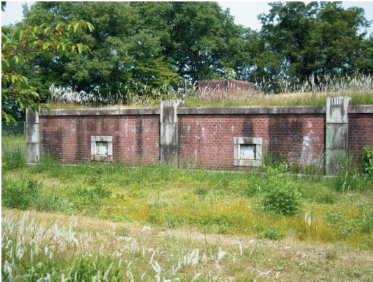
佐波浄水場配水池(側面)
