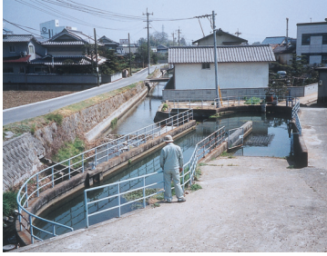
井溝最上流の芦田川からの樋門出口
