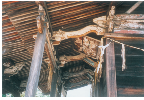
庇下の海老虹梁と木鼻
