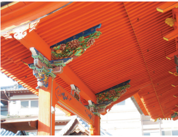
修理、彩色された向拝の内側
