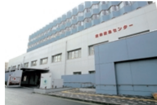
福山市民病院救命救急センター
