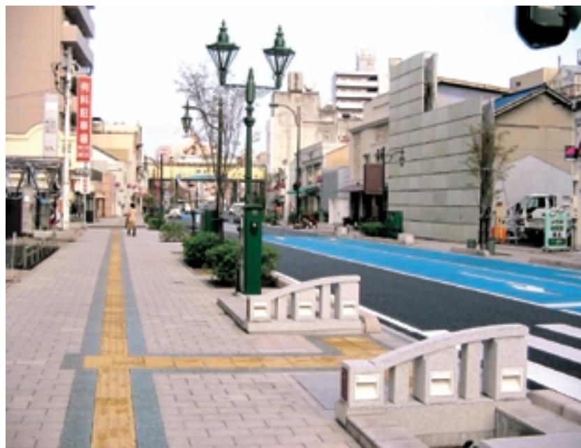
入江をイメージしたシンボルロード(電線類地中化) [船町北交差点付近]
