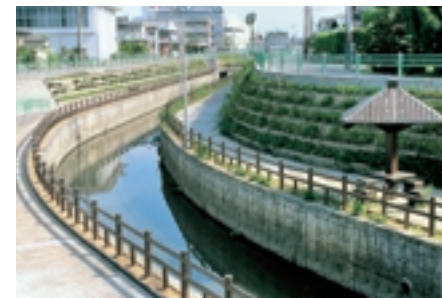
松永クリーク整備(遊歩道のある親水空間)
