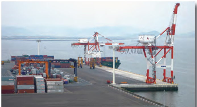
福山港国際コンテナターミナル第2バース
