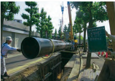
災害に強い水道管の布設
