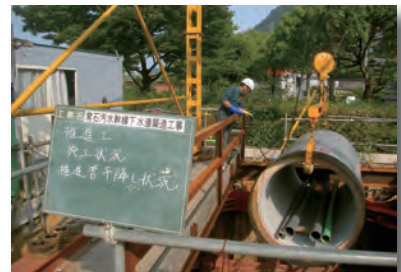
下水道幹線埋設工事
