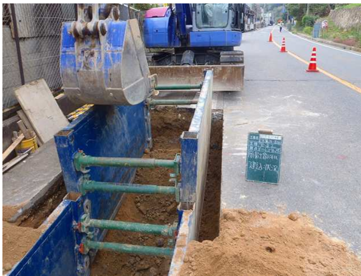
土留め設置状況
