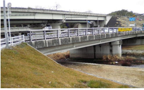
①東大橋西詰
