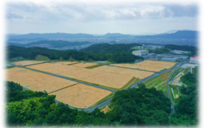
福山北産業団地第2期工事完成
