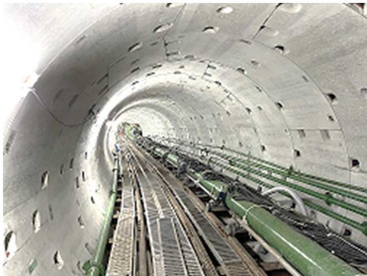
◀ 蔵王雨水幹線 (工事中の様子)
