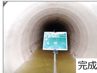
▲ 下水道管路の強靱化（下水道管渠耐震化工事）
