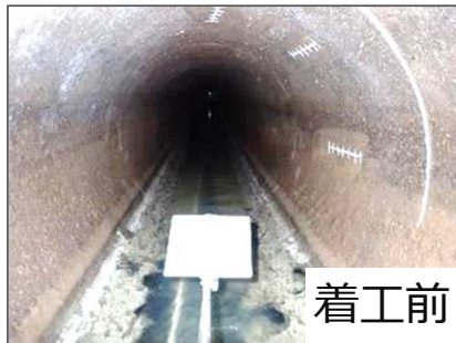
▲ 下水道管路の強靱化（下水道管渠耐震化工事）
