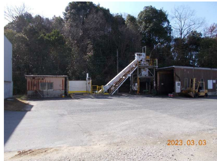
④⑤ 洗車場・倉庫
