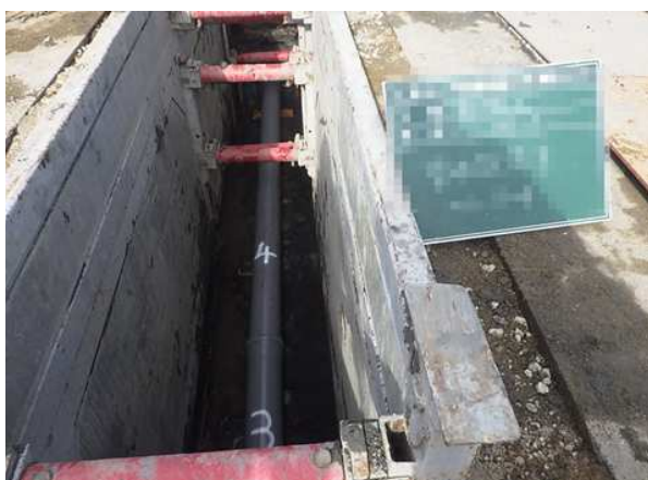
円形管埋設工事
