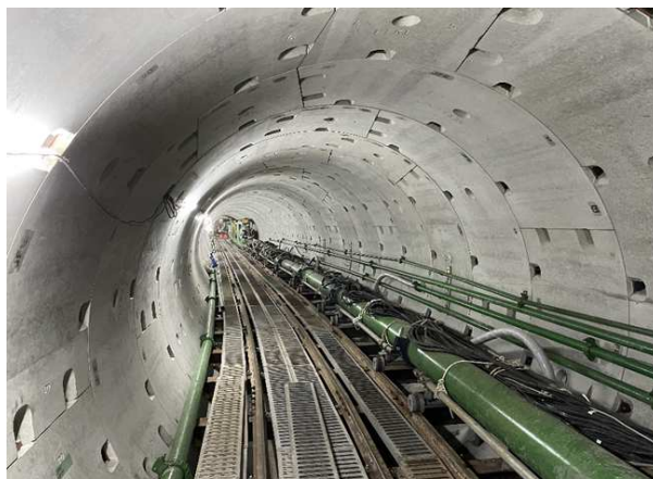
蔵王雨水幹線建設工事
