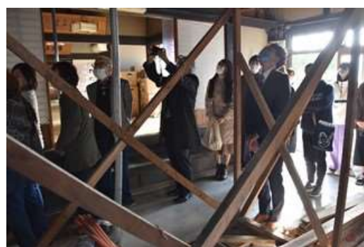
古民家リノベ工事現場見学会
