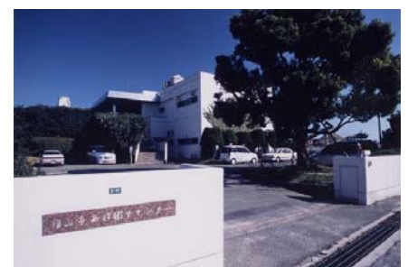
松永し尿処理場
