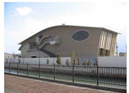
中央ポンプ場
