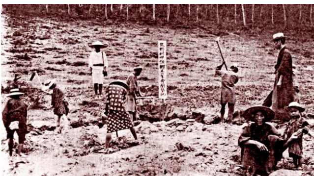
開墾して水田化する工事・沼隈郡熊野青年会
