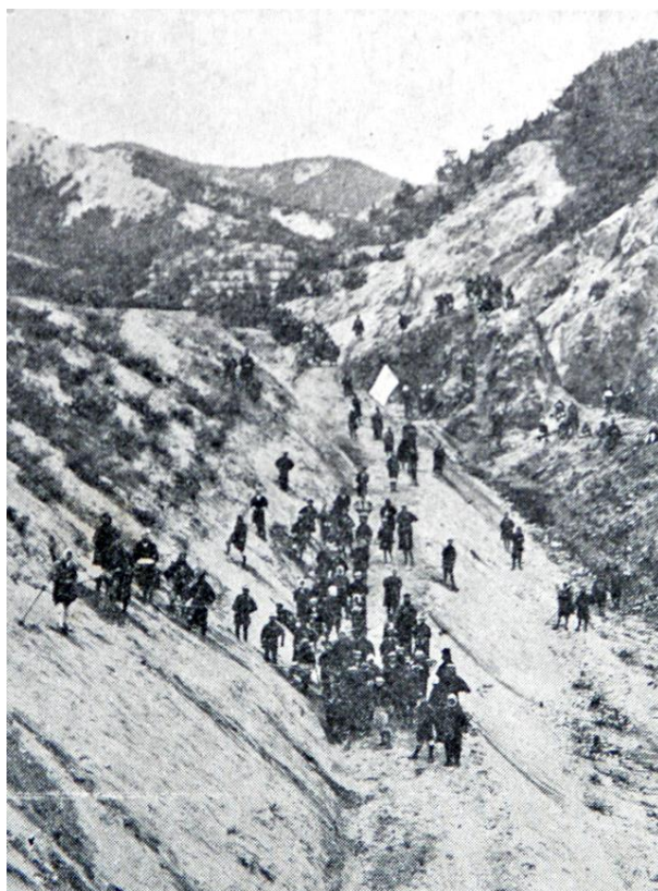
沼隈郡赤坂村鈴池に至る谷間の村道改修作業 沼隈郡赤坂村青年会
