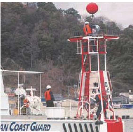
〔灯台の点検・整備〕
