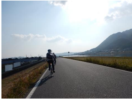
▲ (市) 芦田川左岸 2 号幹線 (左岸堤防天端) 【区間 2-①】
