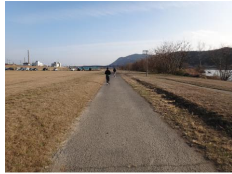
▲ 芦田川左岸河川敷 【区間 2-②】
