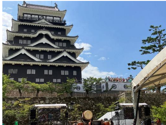
福山城天守北側の鉄板張り復元
