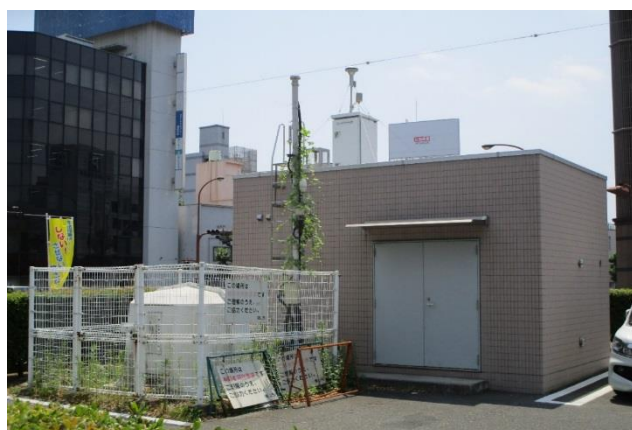
大気汚染常時監視測定局舎(市役所・自排局)
