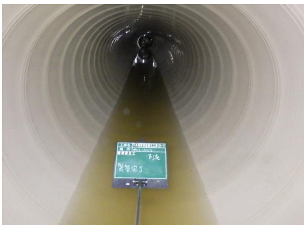
下水道管渠耐震化工事
