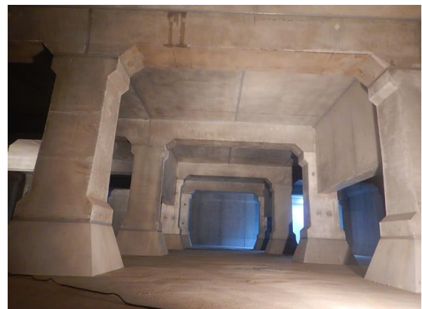
機織排水区雨水貯留施設築造工事(その2)
