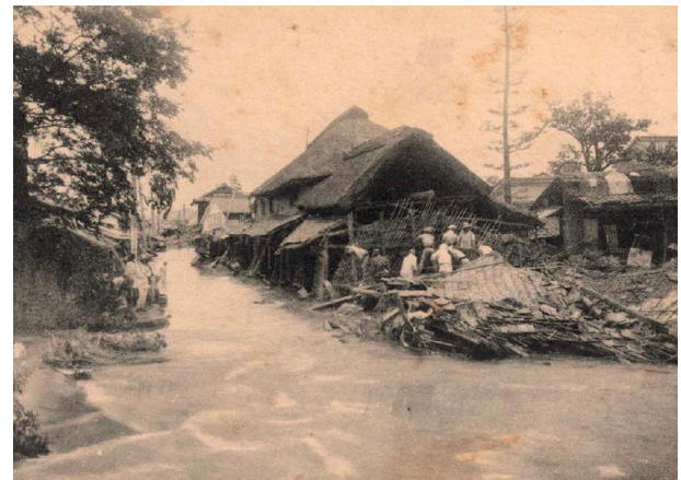
〔濁流により倒壊した民家〕
