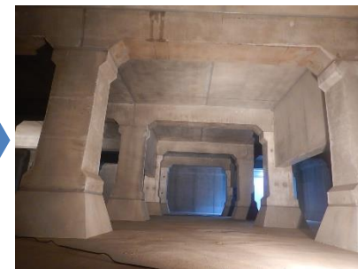
【雨水貯留施設整備（松永中学校グラウンド地下）】
