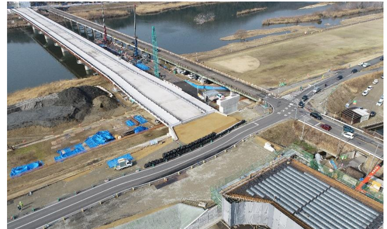
【草戸大橋（福山沼隈道路の側道橋）工事状況】
