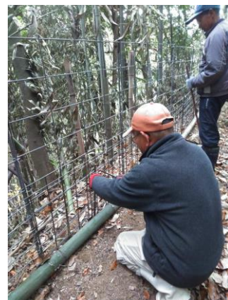
柵の補強・補修作業
