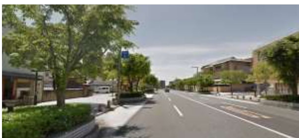
改修前のシンボルロード
