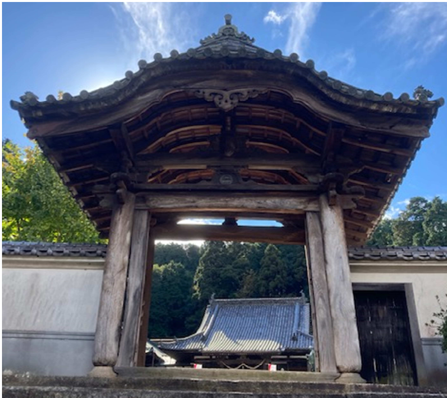
唐門正面（参道階段側より 開扉状態）
