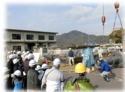
▶ 【導水ポンプ取替工事現場見学会】 ▶
