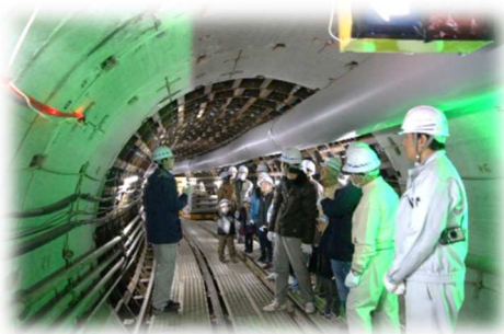
◀ 【浸水対策工事現場見学会】
