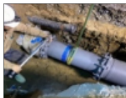
水道管路の更新・耐震化
