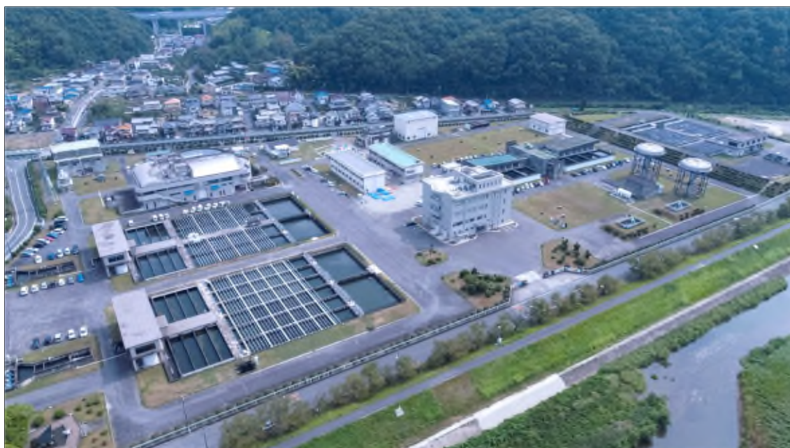
中津原浄水場 全景
