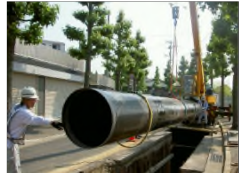
口径 700mm 以上の水道管布設替工事 木之庄町
