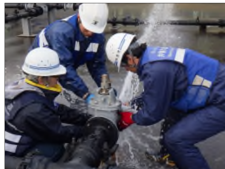
福山市上下水道局防災訓練 2020.1.17
