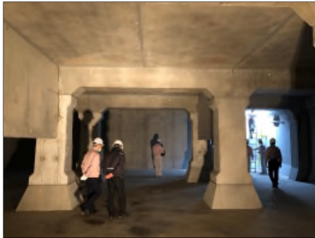
機織排水区雨水貯留施設の内部
