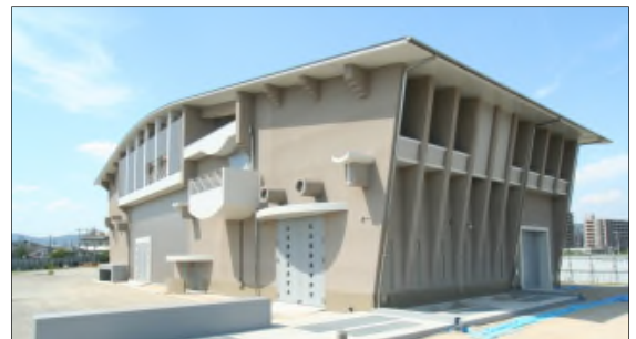
中心市街地の雨水を排除する中央ポンプ場
