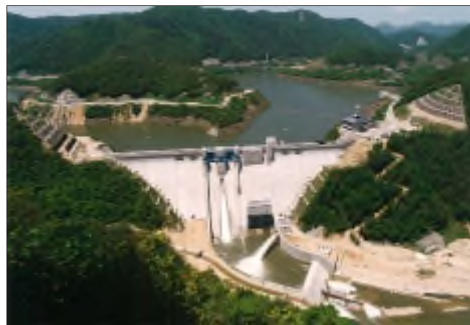
八田原ダム(八田原ダム管理所提供)
