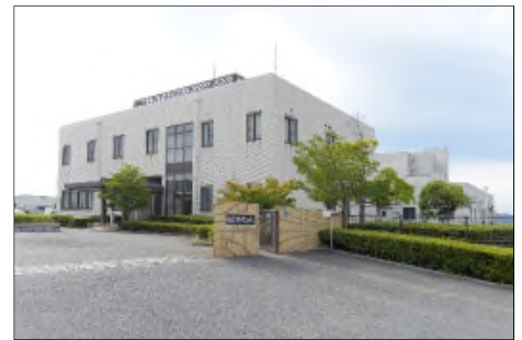
松永浄化センター
