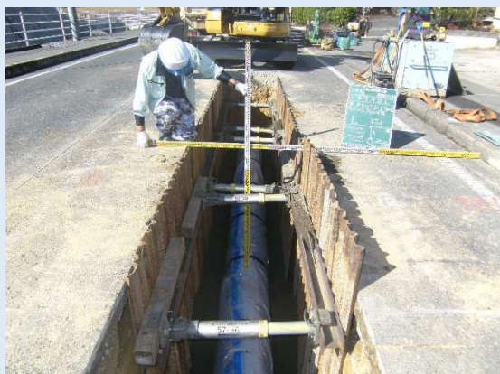
GX 形ダクタイル鋳鉄管 口径 400mm
