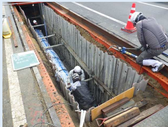
水道配水用ポリエチレン管 口径 75mm
