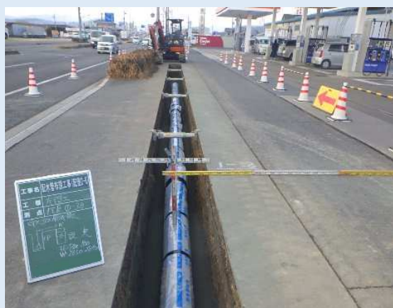
GX 形ダクタイル鋳鉄管 口径 300mm
