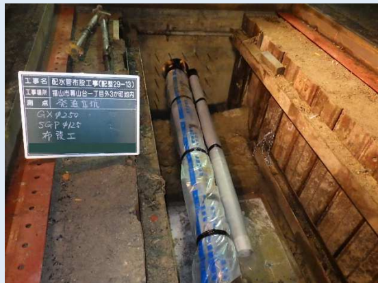
GX 形ダクタイル鋳鉄管 口径 250mm
