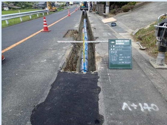
GX 形ダクタイル鋳鉄管 口径 250mm
