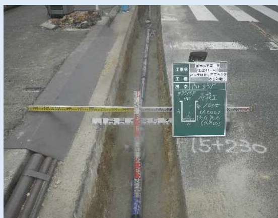
水道配水用ポリエチレン管 口径 75mm
