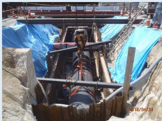
GX 形ダクタイル鋳鉄管 口径 300mm
