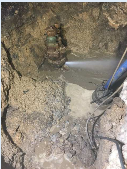
フランジ部からの漏水(消火栓)
