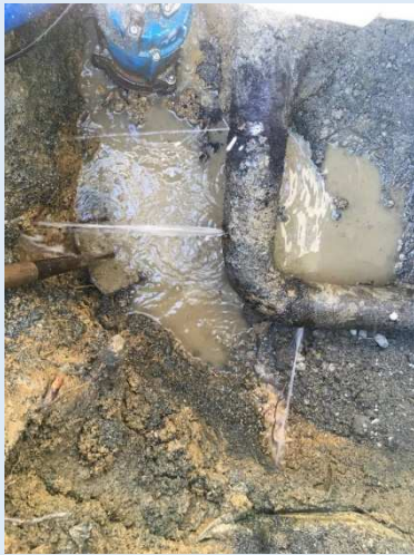
ソケット部からの漏水(塩化ビニル管)
