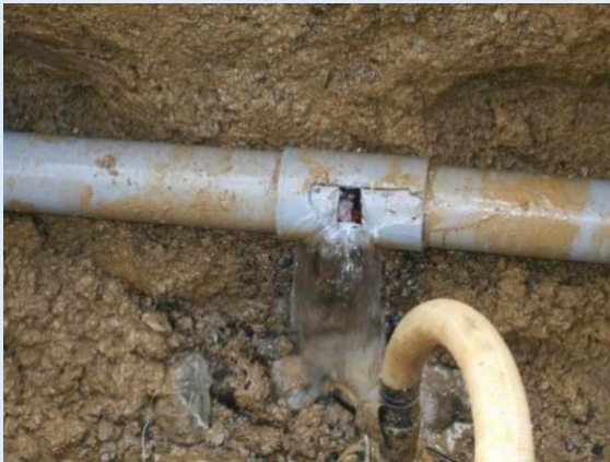
フランジ部からの漏水(消火栓)
