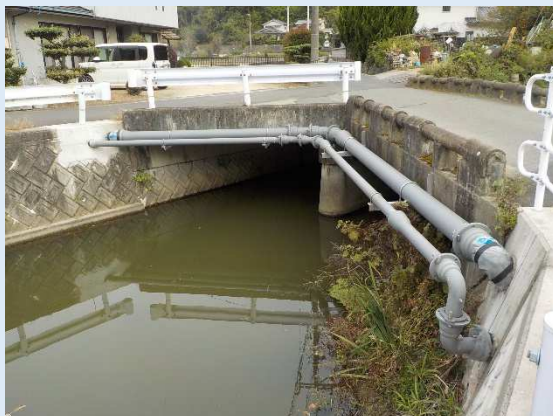
【橋梁添架】GX 形ダクタイル鋳鉄管 口径 200mm
