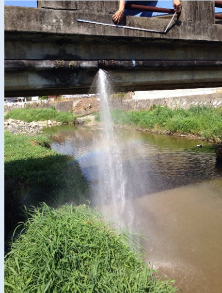
工業用水道の漏水(鋼管)
