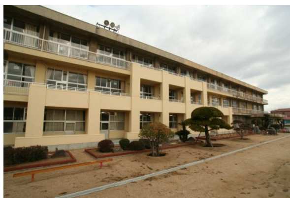
耐震補強工事後の校舎
